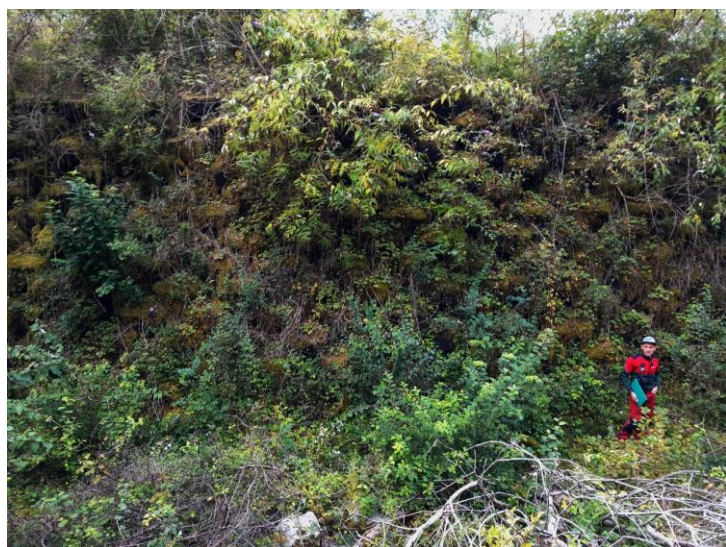
Vue du parement amont végétalisé
