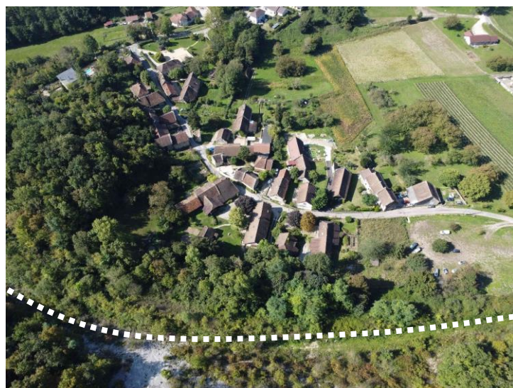
Vue aérienne de l'ouvrage avec l'éboulis vif qui vient s'appuyer sur
