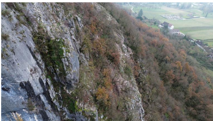
Vue aérienne vers le Sud de la masse B (au niveau du changement de direction de la corniche)
