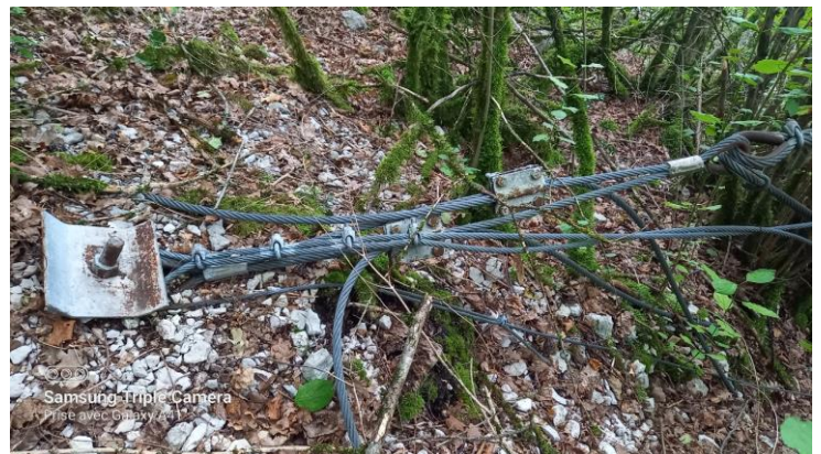
Système d'ancrage amont avec barre à filetage continu, plaque de répartition, serre-câbles changés et plaque de frein d'origine
