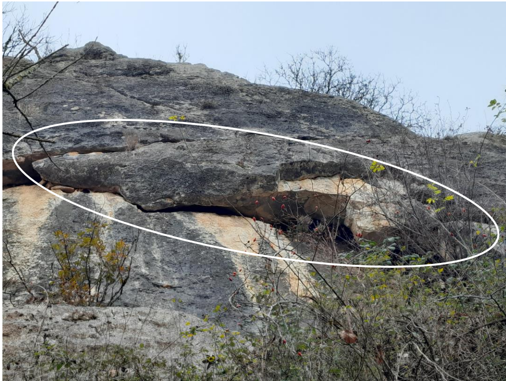
Doc 11. Vue en contre plongée du compartiment A
