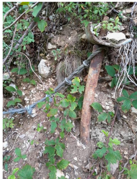
Ancrage d'hauban aval mis à nu dans le talus amont du chemin forestier
