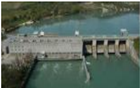
Barrage de Verbois
